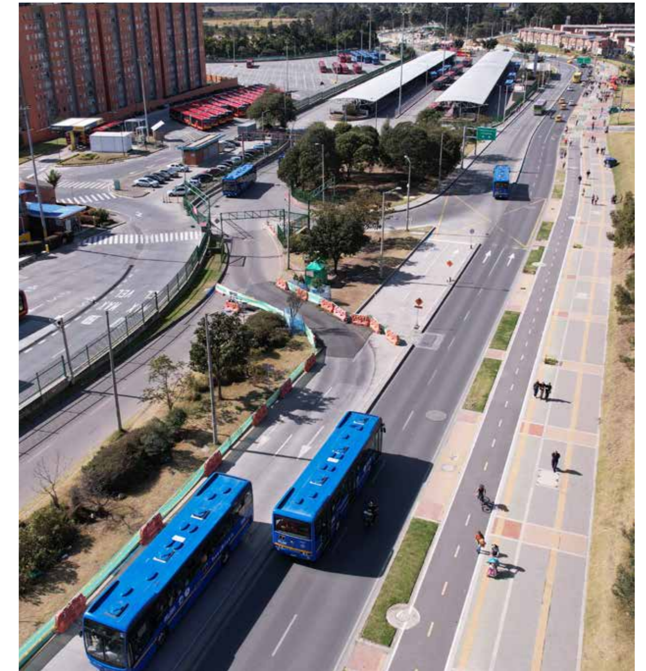
Extensión de la Avenida Caracas Sur entre la calle 56 sur y el Portal Usme
