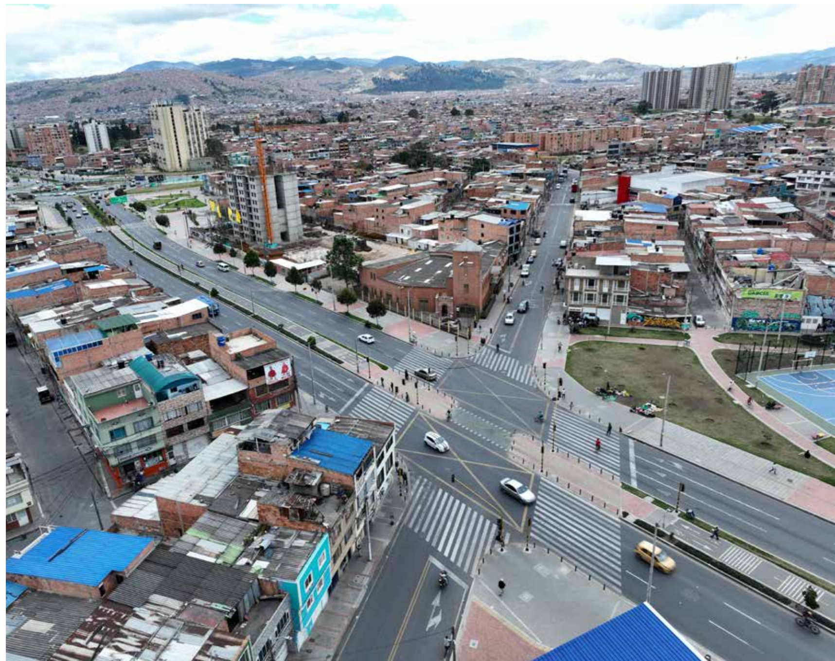
➤ Avenida Guayacanes primer tramo carrera 89 con calle 60 sur. Obra finalizada.
